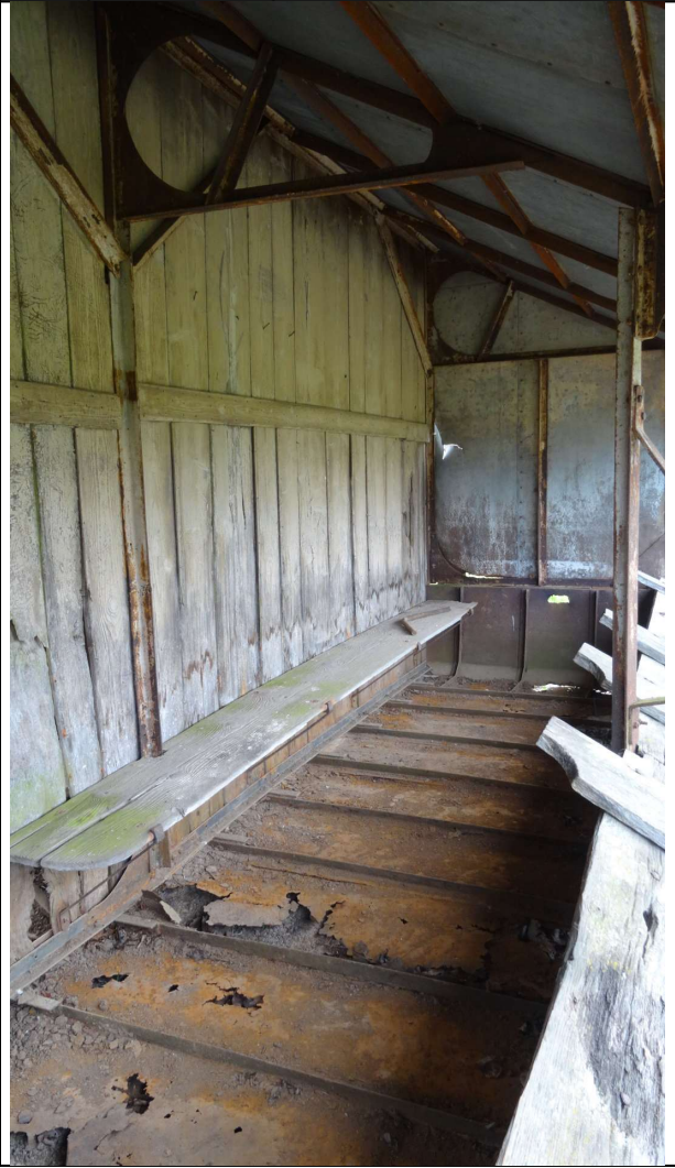
Sous plancher coté passerelle
